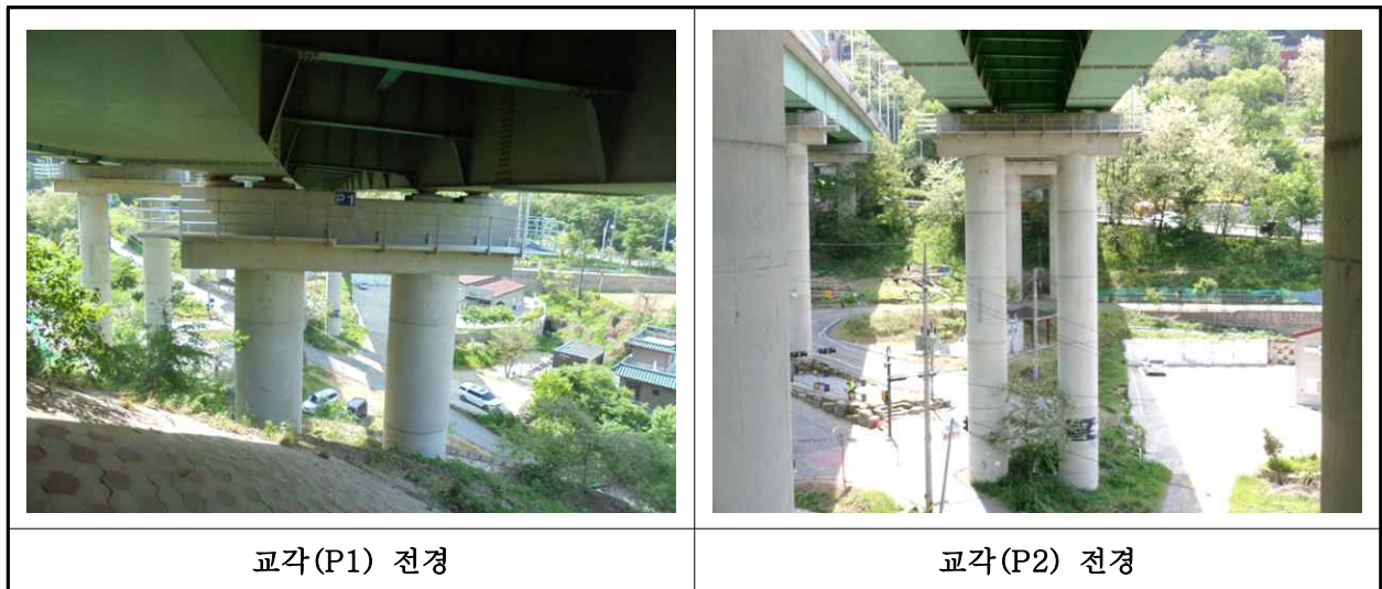
【사진 1.3.10】 교각 전경
