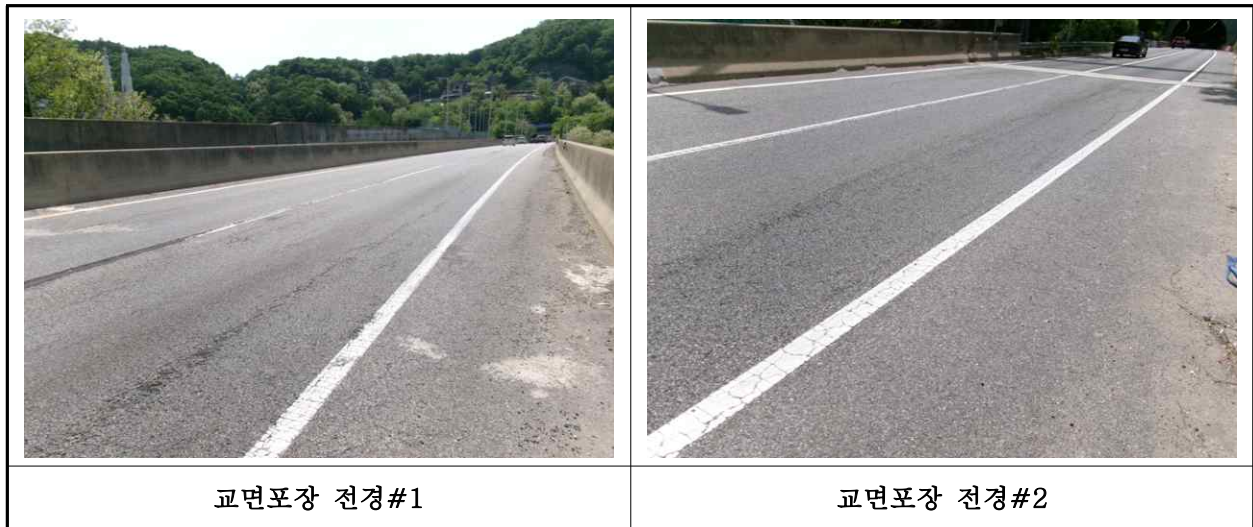
【사진 1.3.20】 교면포장 전경
