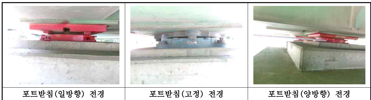
【사진 1.3.12】 교량받침 전경
