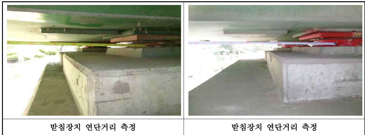
【사진 1.3.14】 교량받침장치 연단거리측정
