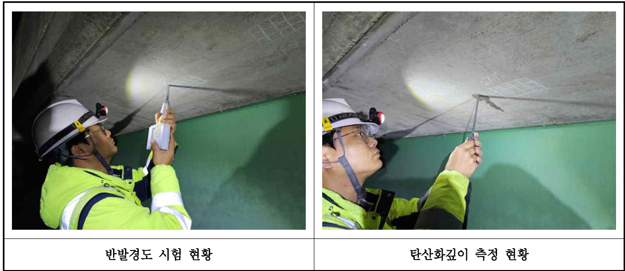
【사진 1.4.1】 콘크리트 내구성조사 현황
