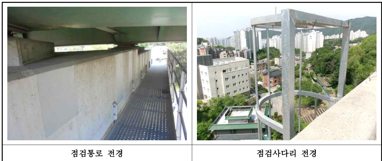
【사진 1.3.26】 교량 점검시설 전경
