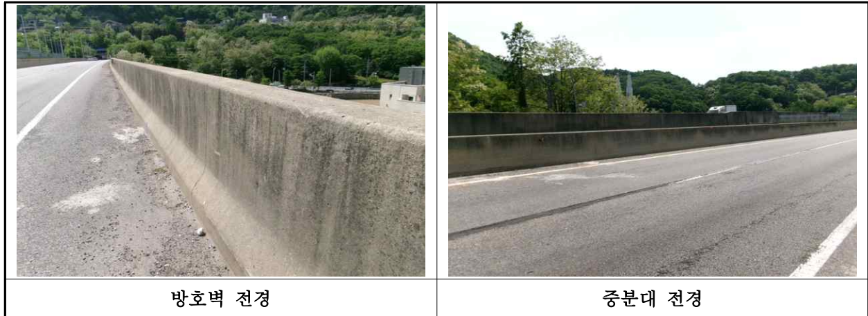
【사진 1.3.24】 방호벽 및 중앙분리대 전경
