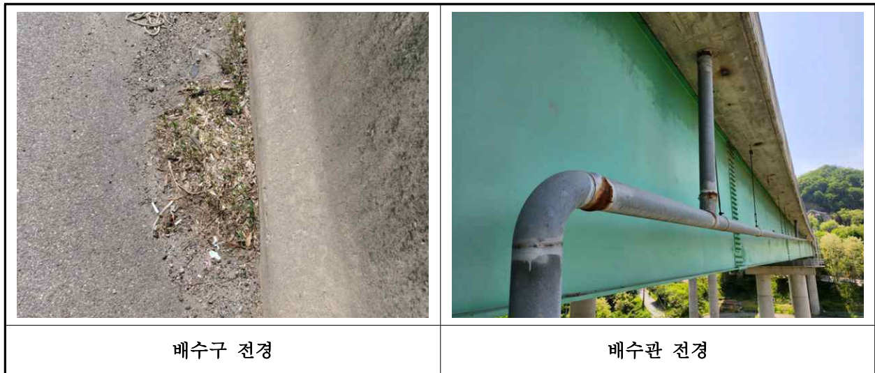
【사진 1.3.22】 배수시설 전경
