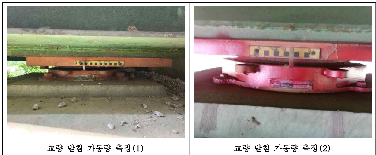
【사진 1.3.15】 교량받침 이동량 측정
