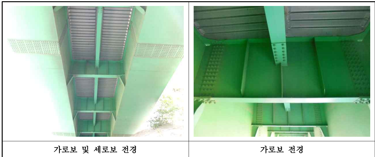
【사진 1.3.6】 가로보 및 세로보 전경
