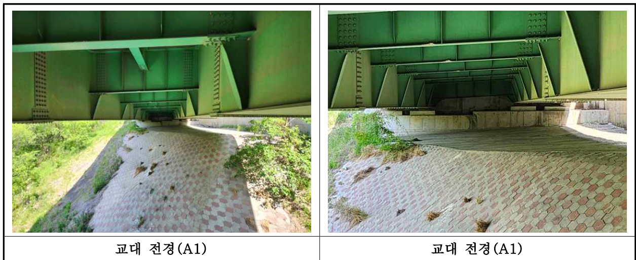
【사진 1.3.8】 교대 전경
