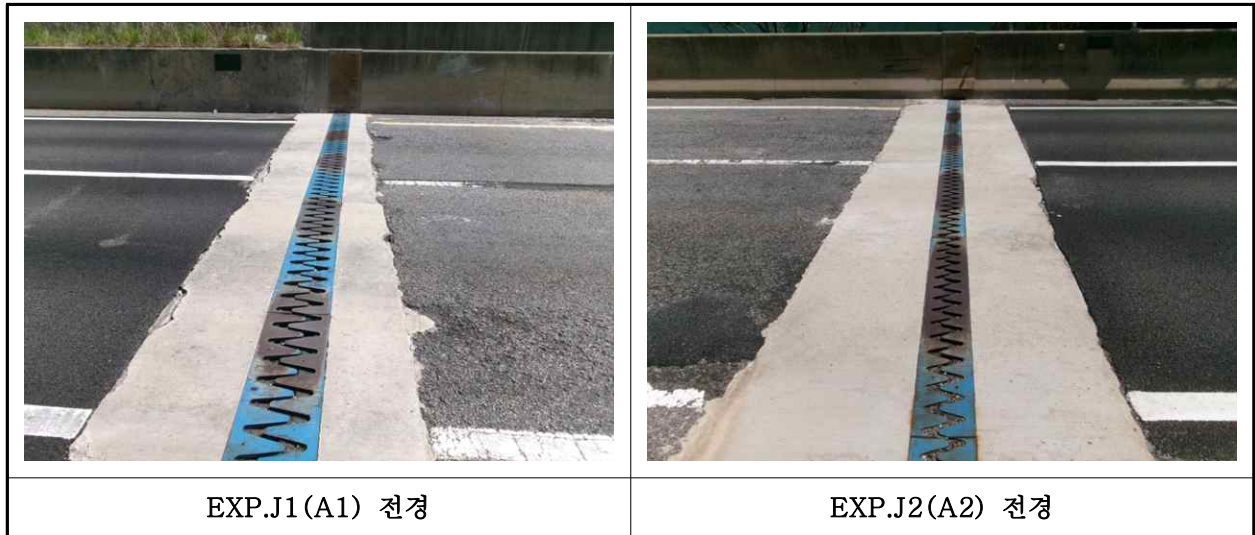
【사진 1.3.17】 신축이음장치 전경
